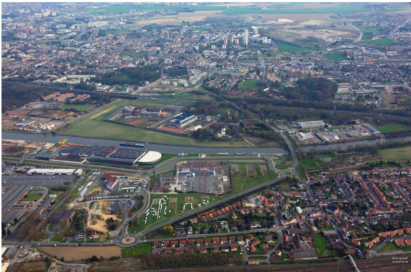
Vue aérienne du secteur des anciens centres pénitenciers de Loos - Source : F. Bocquet, juin 2012
